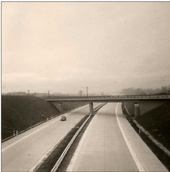
Autobahn A 44, Blick in Richtung Lichtenbusch, hier: Von der Überführung Nordstraße auf die Überführung der Vennbahn
